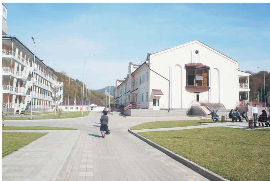
Новое здание инфекционной больницы № 2, п. Дагомыс
